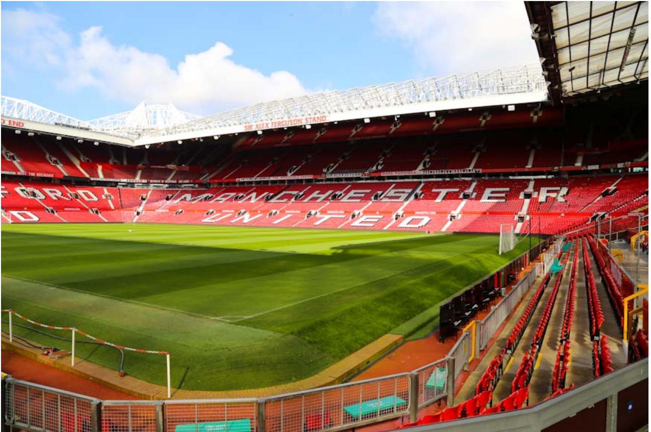
Jubel-Möglichkeit für fast 76.000 Zuschauer in Großbritanniens größtem Stadion mit dem europaweit größten freitragenden Dach
